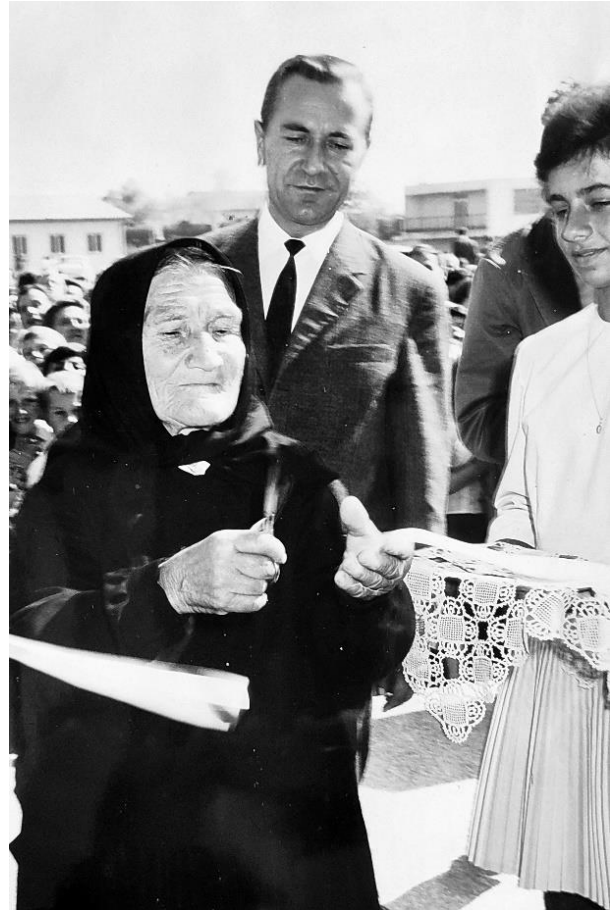
Slika 37 Kata Bobetko presijeca traku prilikom otvaranja gradilišta
